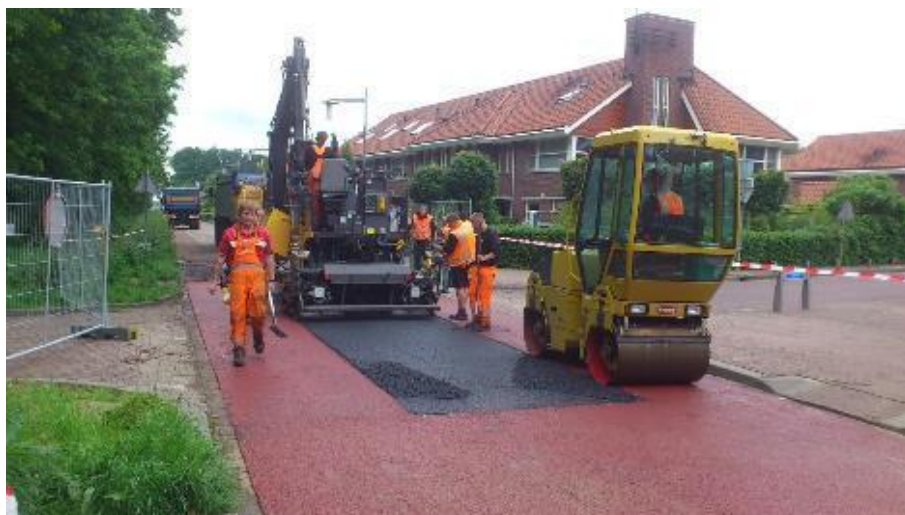
תמונה ב.5: יישום חומר הגוונה אדום בהולנד לנתיב תחבורה ציבורית (מקור: http://www.roelofsgroep.nl/projecten/onderhoud-busbaan-kernhem-te-edo )
