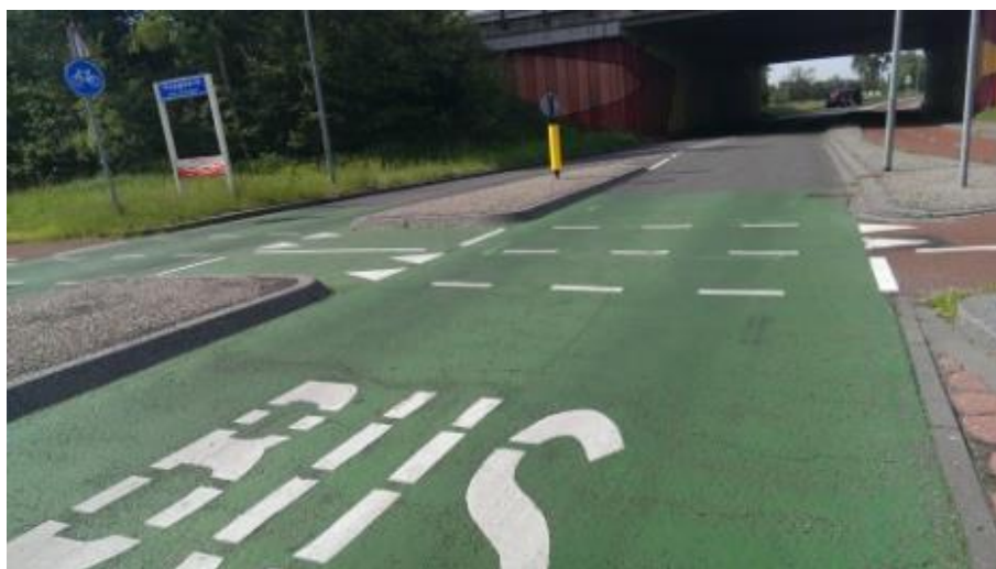
תמונה ב.6: יישום חומר הגוונה ירוק בהולנד לנתיב תחבורה ציבורית (מקור: http://www.oogtv.nl/2014/01/tunnel-onder-busbaan-eemsgolaan/ )
